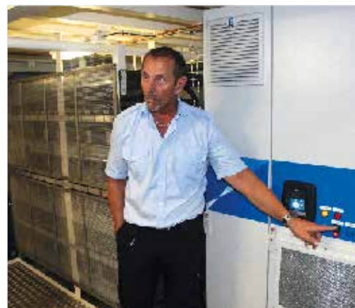
Søren Adersen在介绍采用VACON® NXC空冷微网变换器的功率变换系统。电池组位于左侧。
